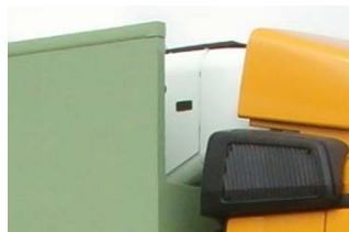
Dachnische ohne Unterbruch der Seitenwand
